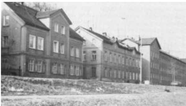
Abb. 8 Straßenansicht des Wohnkomplexes Schweinfurter Straße 39 - 53 (1883/84). Foto: H. Zwirner 1984
